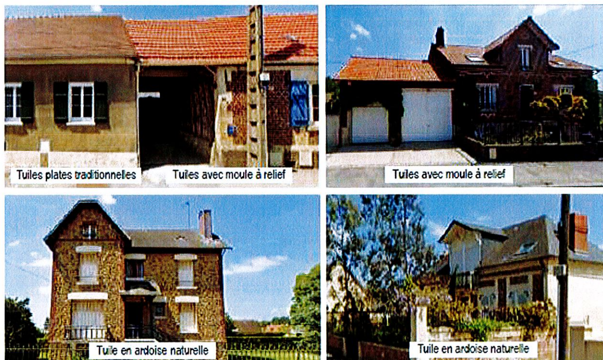
Illustrations des matériaux et aspects des toitures
